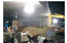
Construction d'une ligne de chemin de fer
