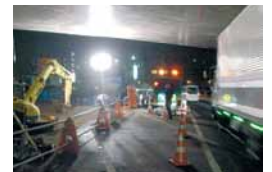
Construction d'une ligne de chemin de fer
