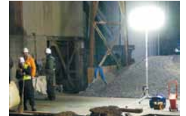
Travaux de voirie
